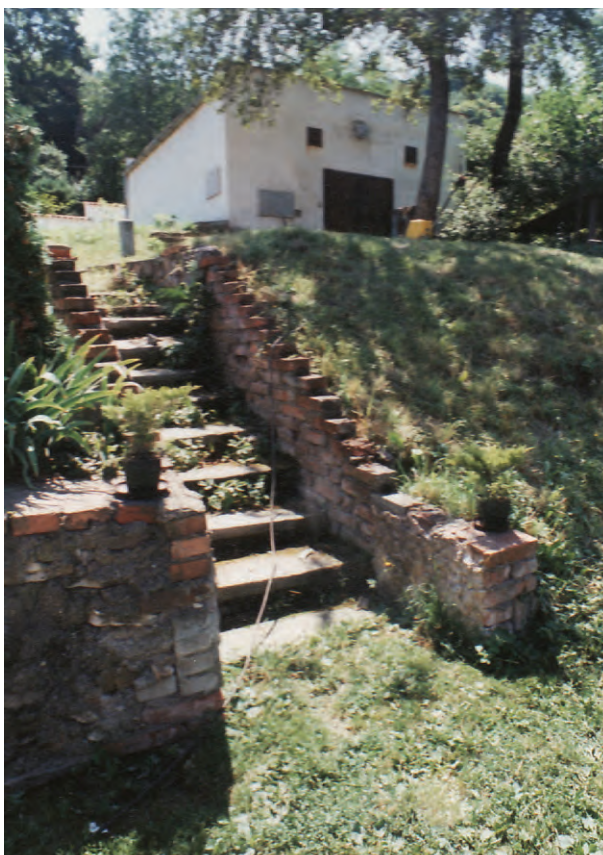
Abb. 176: Haus Nazareth, Treppenanlage, Fotografie, Verfasser unbekannt, ohne Datum, vor 1998
