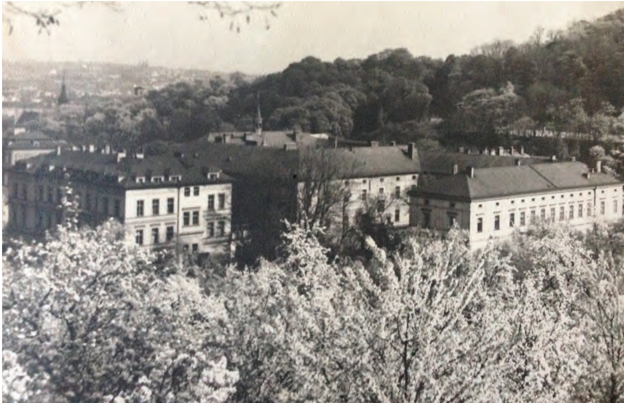
Abb. 043: Ansicht von Nordwest auf Hospital, Fotografie, Verfasser unbekannt, 1932
