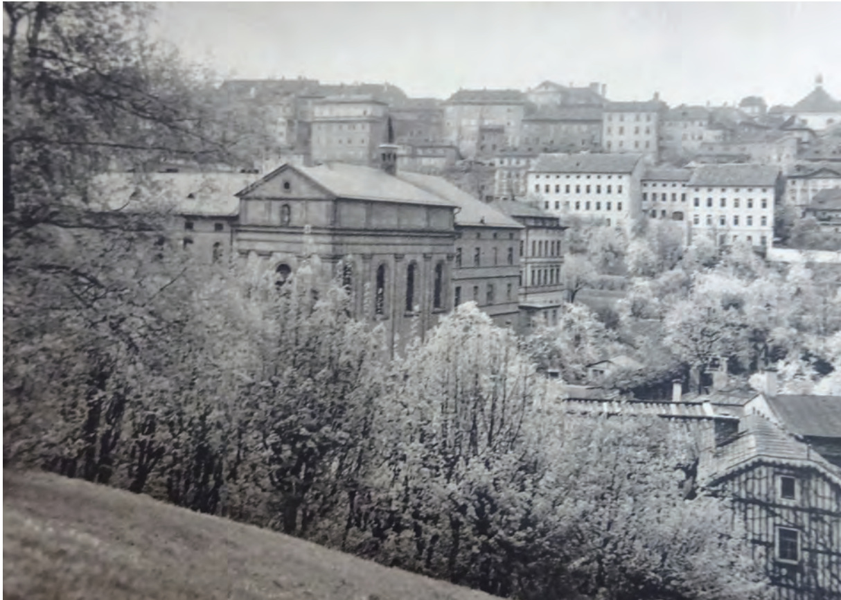
Abb. 053: Blick auf die Kirche vom Hl. Karl Borromäus mit Krankenhaus, Postkarte, postalisch nicht gelaufen, Fotografie, Verfasser unbekannt, ohne Datum, zwischen 1932 und 1937
