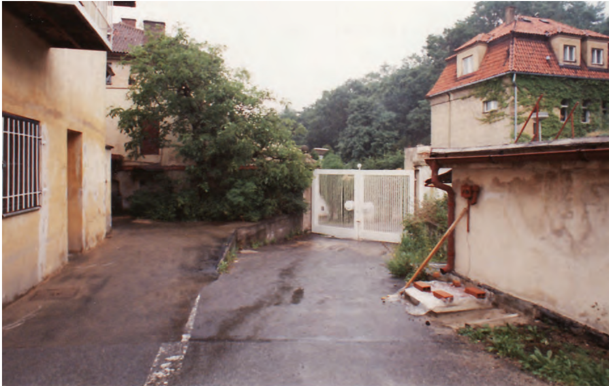
Abb. 163: Technischer Bereich, Zufahrt von Vlašská , Fotografie, Verfasser unbekannt, ohne Datum, vor 1998
