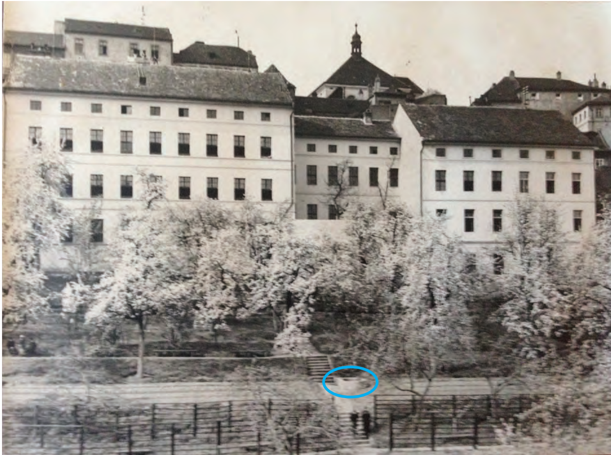
Abb. 055: St. Karolusgarten mit Schulgebäude zum Hl. Kreuze, Ansicht von Süden, Fotografie, Verfasser unbekannt, ohne Datum, zwischen 1932 und 1937
