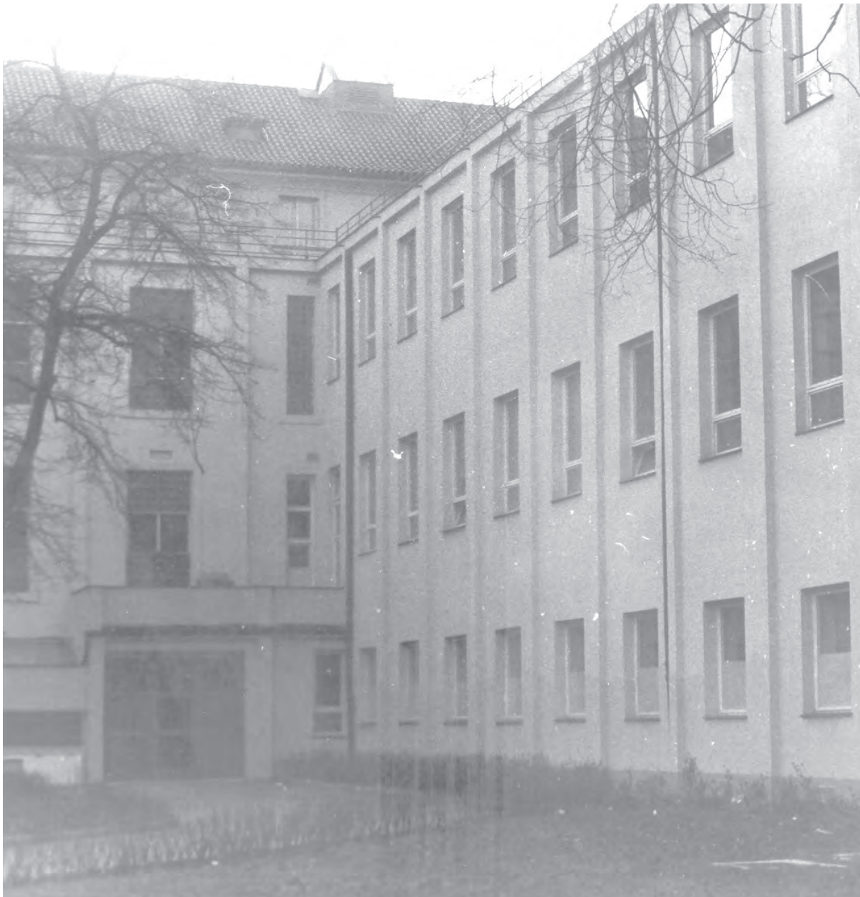
Abb. 136: Fertigstellung des Anbaus an Ostfassade des Krankenhausflügels „St. Antonius“, Fotografie, Verfasser unbekannt, Sommer 1970
